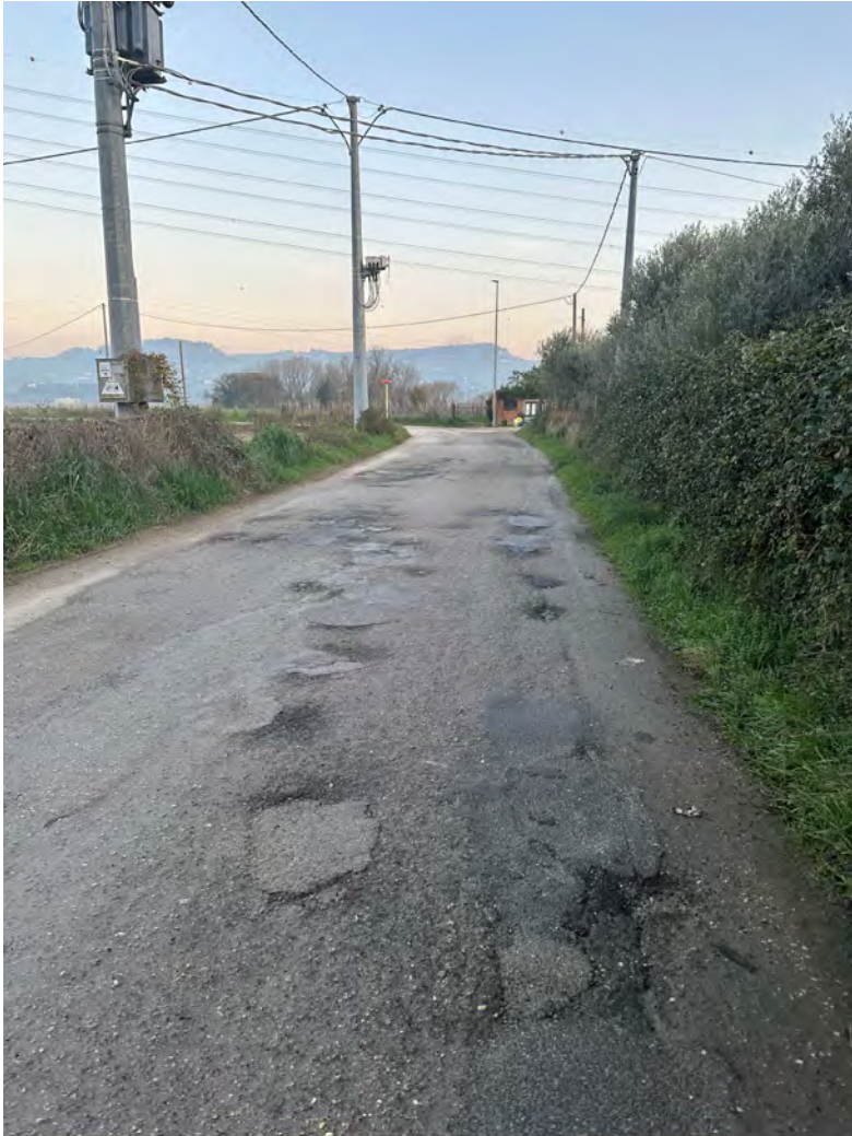
5) Via Piemonte (tratto dopo cavalcavia)
