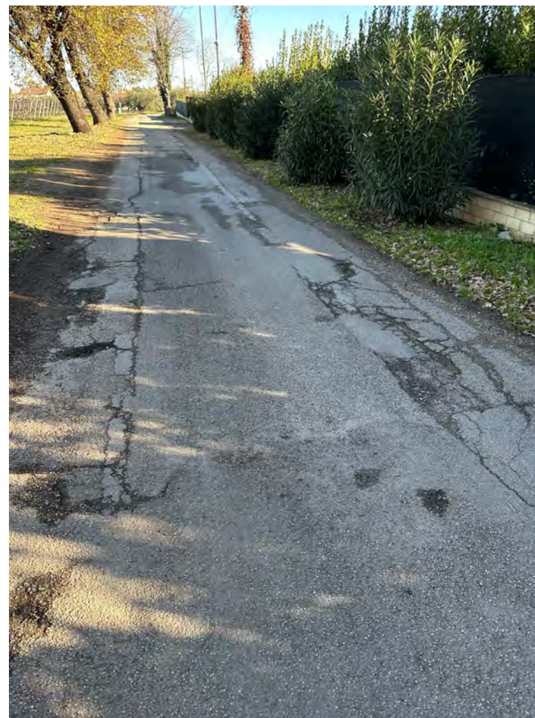
12) Via Mococitto (tratto iniziale)
