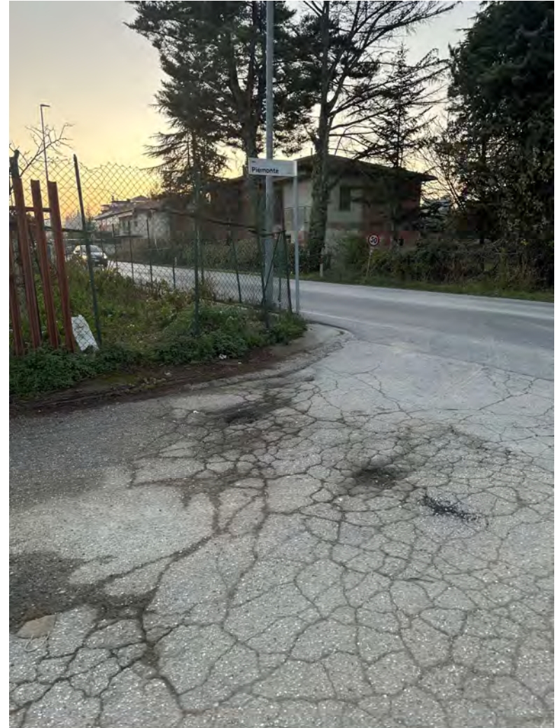
5) Via Piemonte (tratto prima cavalcavia)
